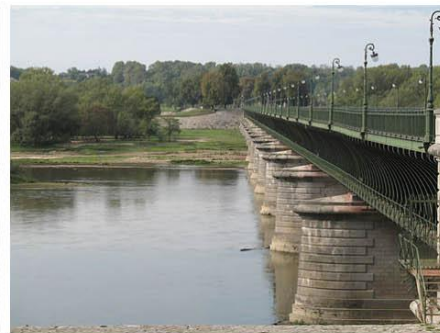
Le pont-canal métallique de Briare (France).
