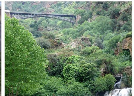
Le pont de chemin de fer aux « Cascades d'el Qurit » à Tlemcen
