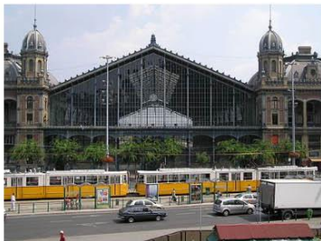
Gare de l'Ouest Budapest (Hongrie).
